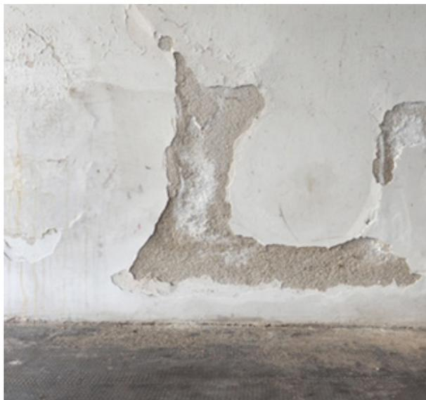
I segni visibili della presenza di una risalita capillare sono i classici distacchi della pittura e dell'intonaco.
